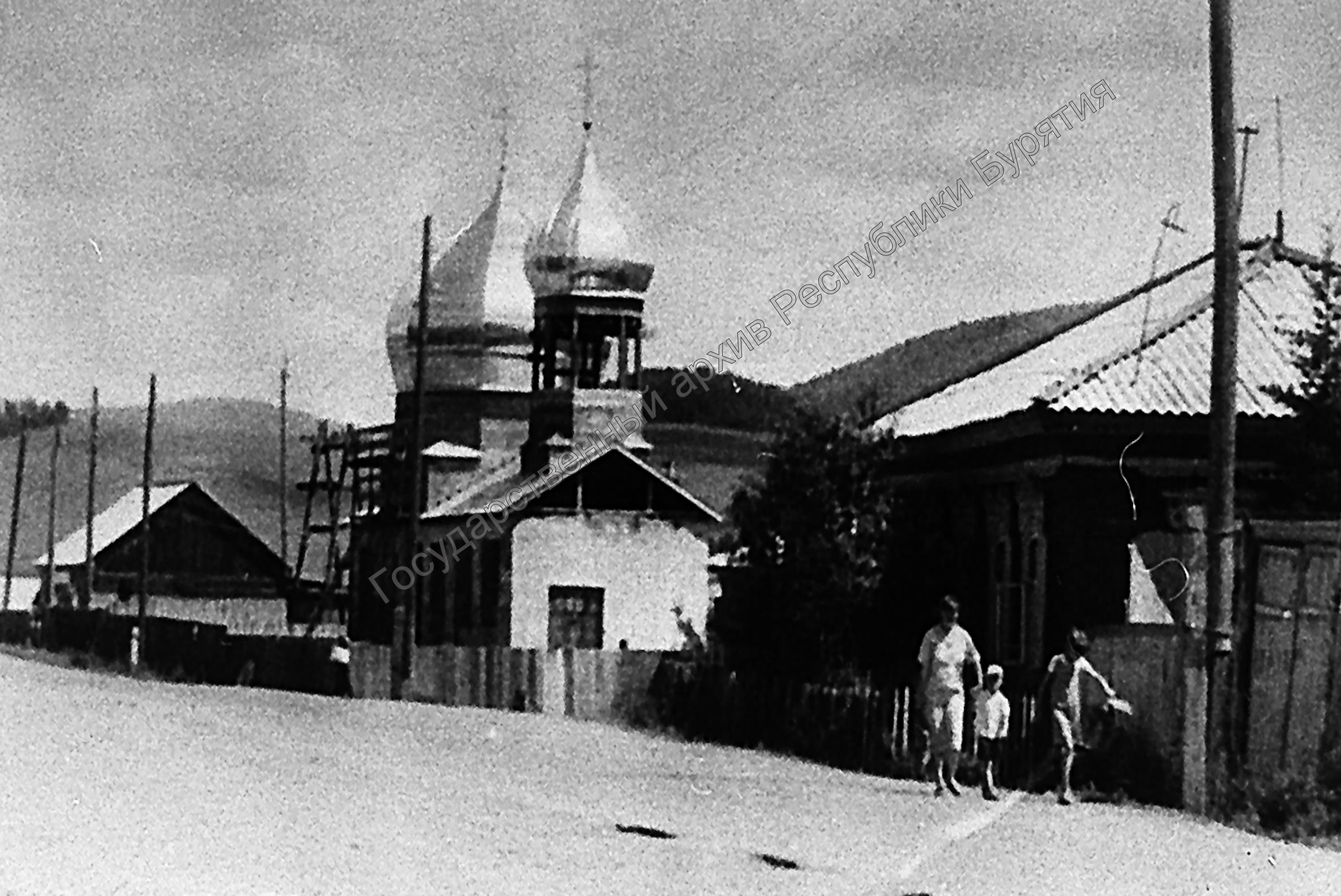
Строительство церкви в с. Куйтун. 1997 г. Фотофонд ГАРБ
